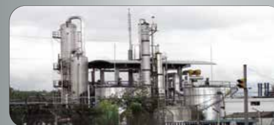
Planta Industrial - INTERQUIMEC
