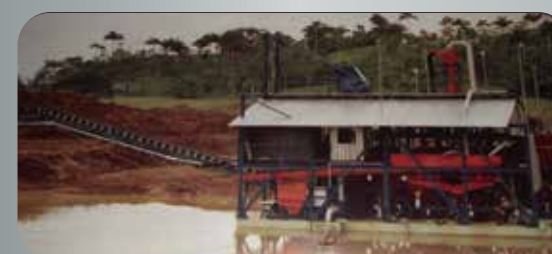
Planta de Lavado de Oro Aluvial - ECUMINAS
